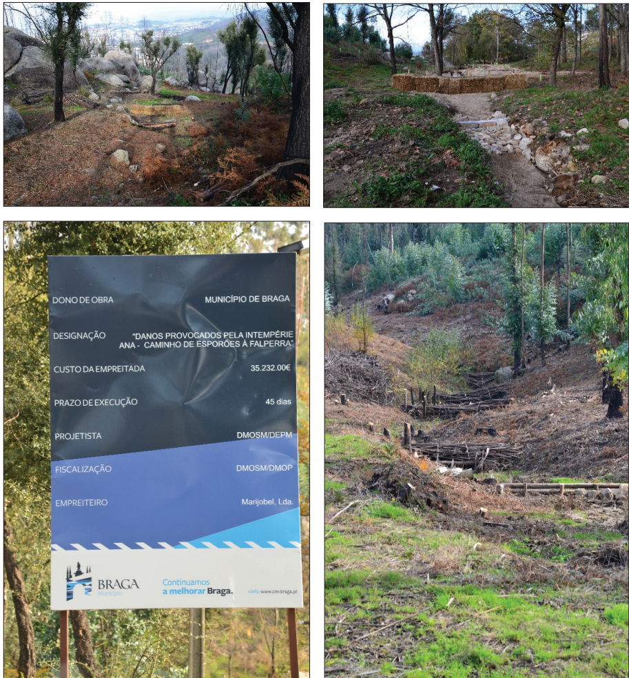
Fot. 6 - Fotos de medidas de mitigação implementadas nas áreas afetadas pela erosão na equência da tempestade Ana (dezembro de 2017) (Fotografias de A. Vieira, 2018).
