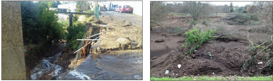
Fot. 2 - Obstrução de infraestruturas urbanas e acumulação de sedimentos em áreas agrícolas (Fotografias da Câmara Municipal de Braga e de António Vieira, 2017).
