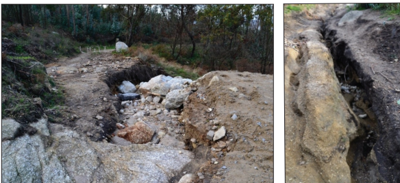
Fot. 5 - Destruição de caminhos por ação da erosão hídrica (Fotografia de A. Vieira, 2018).
