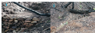
Fig. 3 - Muros e aglomerados de ramos implantados em linhas de água para retenção de sedimentos.
